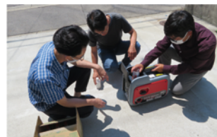
災害用発電機チェック
