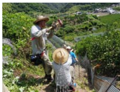
防護柵設置作業
